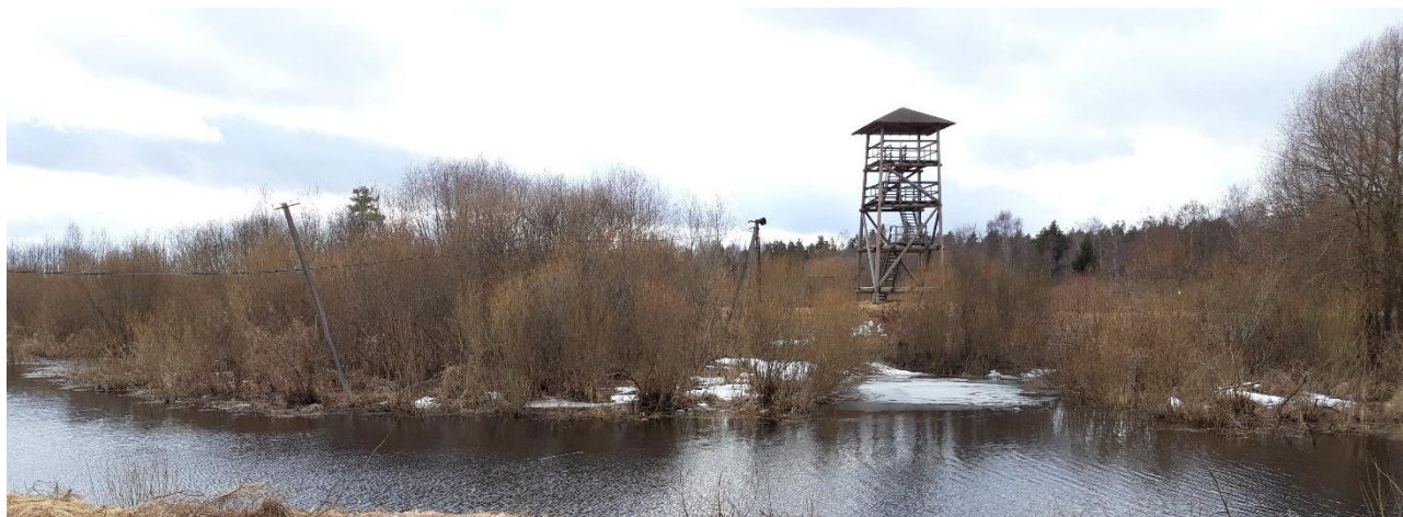
Foto 1. Tellise tee 8 kinnistul paiknev vaatlustorn (Foto: Kobras OÜ, pildistatud 05.04.2022)
