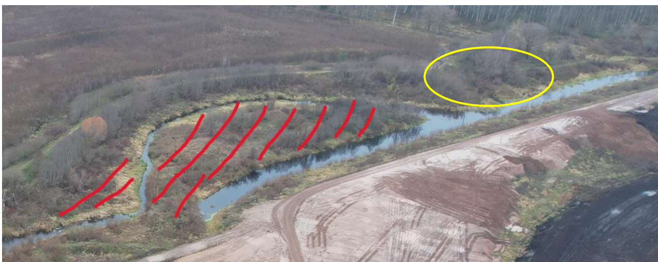
Joonis 42. Kavandatava sadama ja akvatooriumi ala. Punase viirutusega on tähistatud akvatooriumi rajamise eesmärgil eemaldatav pinnas, kollane ovaal tähistab kavandatava sadamahoone asukohta (allikas: Ilmatsalu Kala OÜ droonifoto, pildistuse aeg 09.11.2024)
